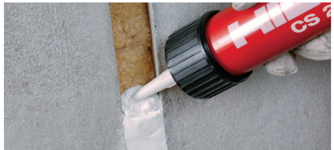
② Fuge Wand zur Wand oder Boden zu Boden.
