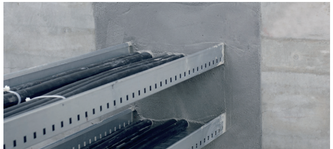
Abschottung sehr großer Durchführungen mit Brandschuttmörtel CP 636.
