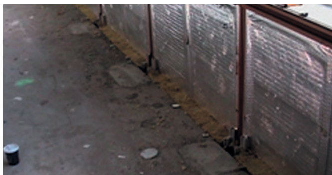
Mit Mineralwolle geschlossener Spalt.
