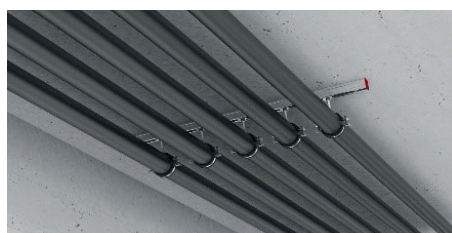
Schiene direkt an der Decke
