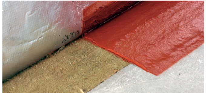
① Fuge Außenwand (Fassade) zum Boden.
