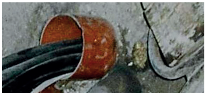
Hüllrohr bündig mit Wand/Decke abschneiden.
