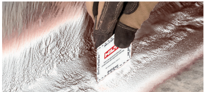
Überprüfung der Dicke des Nassfilms.
