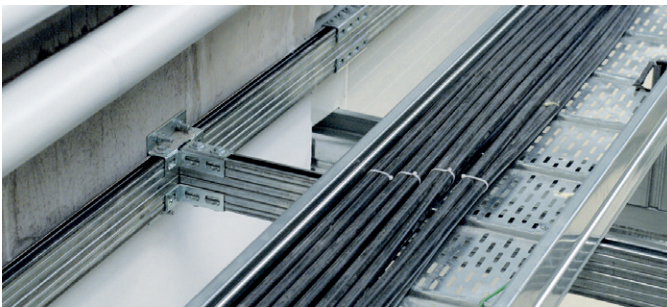
Verlegung von Kabeln.
