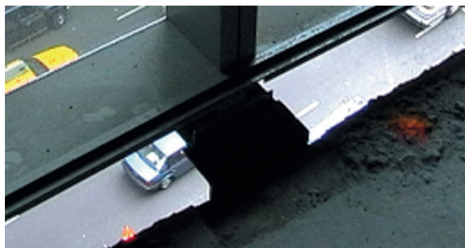
Offener Spalt zwischen Fassadenelement und Decke.
